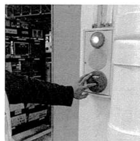
ภาพที่ 7: Manual call point Operate
